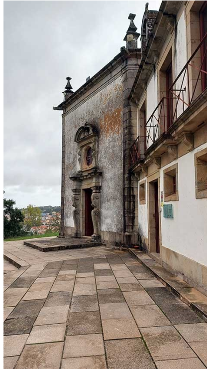
Esterno della Capela de Nossa Senhora da Encarnação
